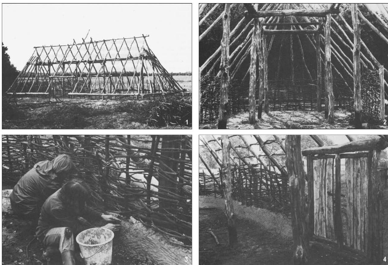
Ryc. 19. Rekonstrukcja domu z okresu przedrzymskiego z Hijken w północnych Niemczech w skansenie w Orvelte. 1 – gotowy szkielet domu; 2 – już wykonana plecionka ścian (widok od wewnątrz); 3 – oblepianie plecionki ścian gliną; 4 – wejście i ściany (widok od wewnątrz) oba elementy domu nie są konstrukcyjnie połączone z jego szkieletem. Wg: O.H. HARSEMA 1980
