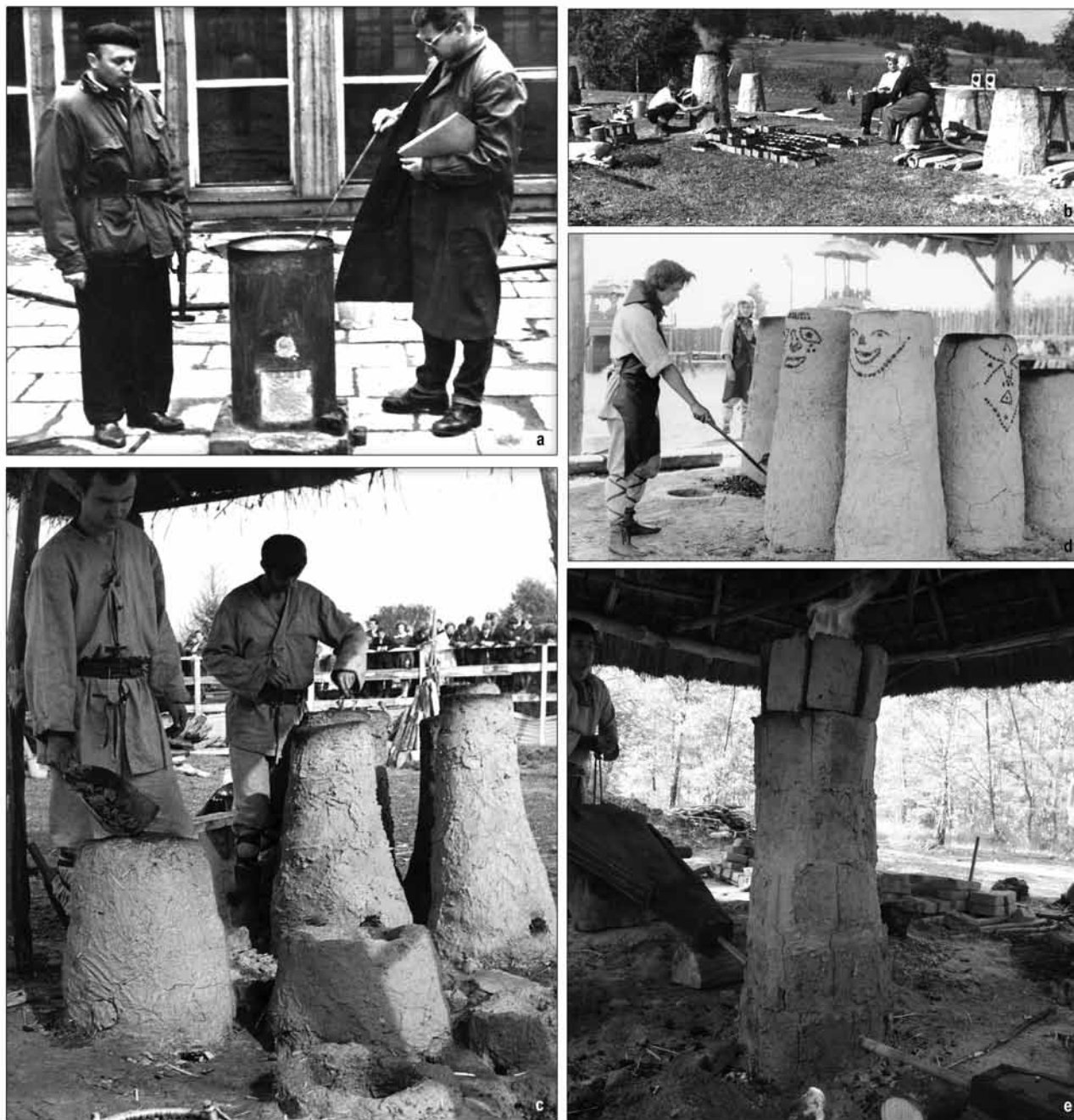
Ryc. 1. Evolucja rekonstrukcji pieców używanych na potrzeby badań eksperymentalnych nad procesem dymarskim: a – prace doświadczalne na terenie AGH w latach 1958–1959; b – wytopy doświadczalne w Nowej Słupi w latach 1962–1964; c, d – eksperymenty dymarskie podczas „Dymarek Świętokrzyskich” w latach 70. XX wieku; e – piec dymarski wykorzystywany w czasie eksperymentu prowadzonego przez Jensa Jørgena Olesena w Starachowicach w 2008 roku. Fot.: K. Bielenin, T. Pilecki i M. Fludziński, Archiwum Akademii Górniczo-Hutniczej im. Stanisława Staszica w Krakowie (dalej: AGH) i Świętokrzyskiego Stowarzyszenia Dziedzictwa Przemysłowego (dalej: ŚSDP) Fig. 1. Evolution of modern replicas of furnaces used in the experimental studies of the bloomery process: a – experimental work at AGH University of Science and Technology, 1958–1959; b – experimental smelts at Nowa Słupia, 1962–1964; c, d – bloomery experiments during the “Holy Cross Bloomeries”, 1970s; e – a bloomery furnace used in the experiments of Jens Jørgen Olesen in Starachowice, 2008. Photo: K. Bielenin, T. Pilecki and M. Fludziński, Archive of Stanisław Staszic University of Science and Technology in Cracow (subseq. AGH) and of the Holy Cross Mts. Industrial Heritage Association (subseq. ŚSDP)
